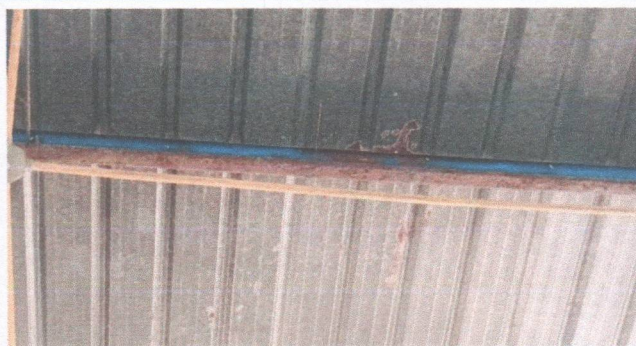
Foto 4: Se observa la necesidad de sustituir la estructura de techo
