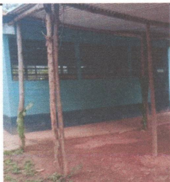
Foto 3: Se observa la necesidad de colocar losa de patio
